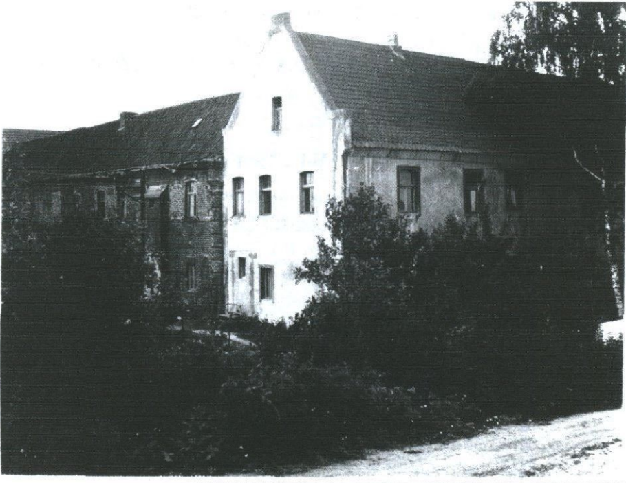
Abb. 11 Haus Bohlordorf. Die Südostseite der Wirtschaftsgebäude mit der vermauerten Tordurchfahrt und das Wohnhaus von Osten (Aufnahme 1968).
